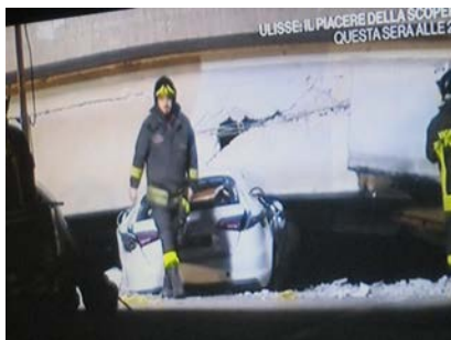
③ 高速道路を走行中の乗用車 が下敷きになり運転手が犠牲に
