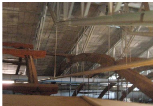
天井及び屋根の補強状況
